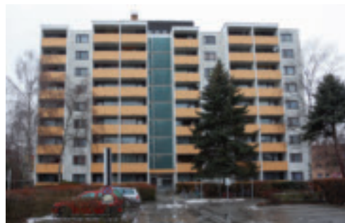
Das Penthouse beherbergt die Heizzentrale.
